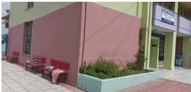
Πριν και μετά την αποκατάσταση
