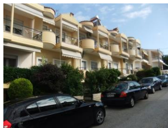
Φωτ. 13. Εργολαβικές κατοικίες με το χώρο στάθμευσης εντός του οικοπέδου να έχει μετατραπεί σε προκήπιο (Ν. Ρύσιο)
