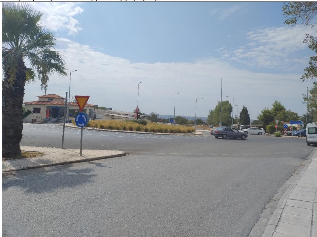
Οδός Ταβάκη – Έξοδος από Θέρμη – Κυκλικός κόμβος επί της ΕΟ16
